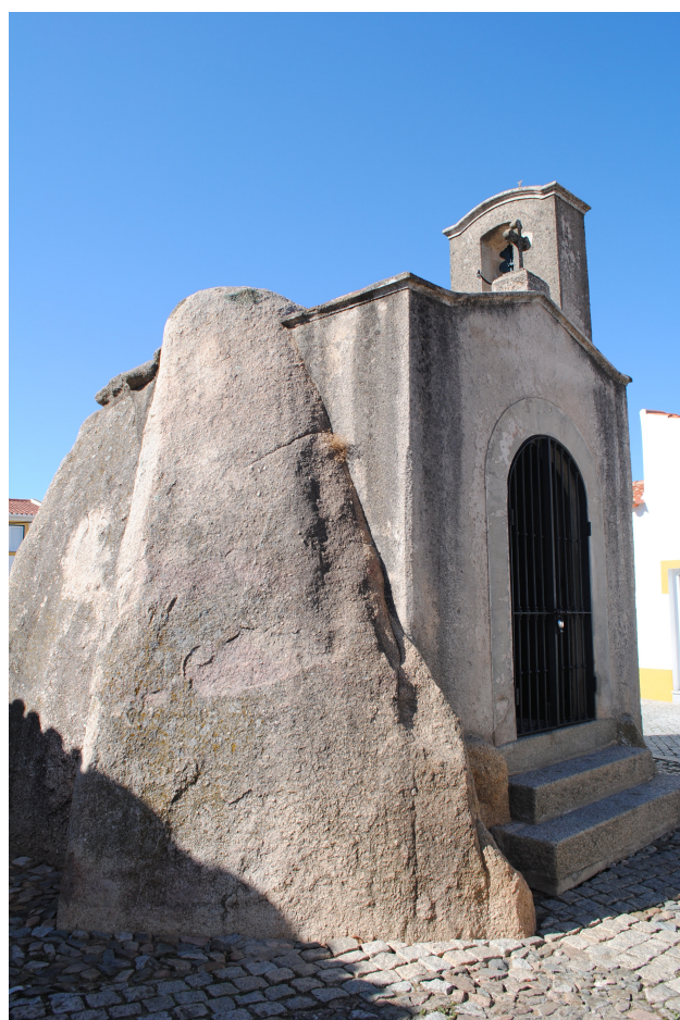
Figura 11. Anta-capela de São Dinis (Pavía, Mora, Portugal). Elaboración propia.
